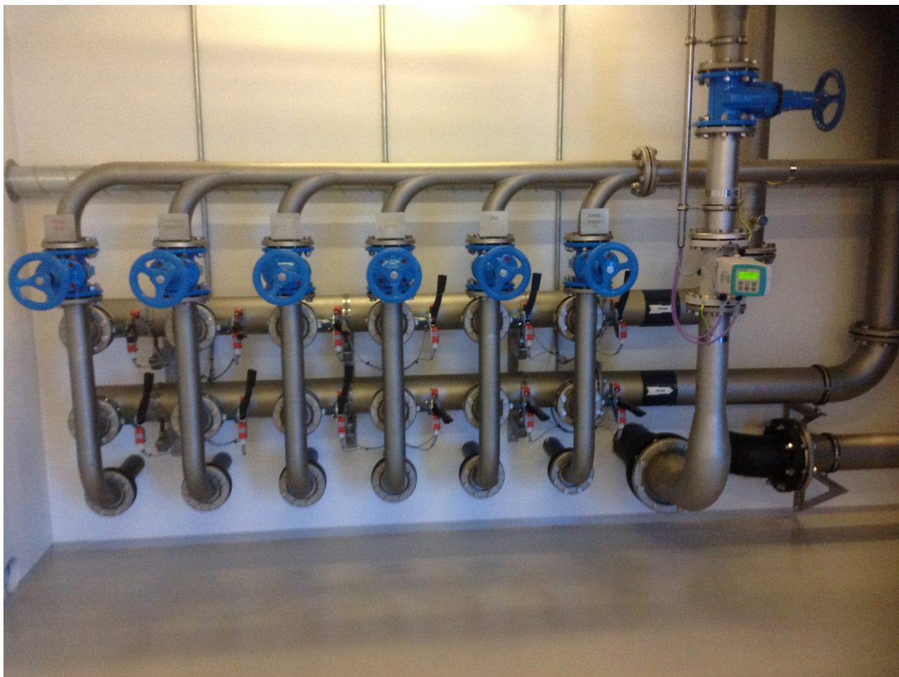
Figur 1: Fordelingsarrangement for råvand, kaldet vandorglet.
