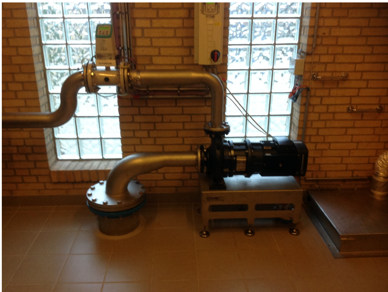
Figur 2: Skyllevandspumpe sektion 4
