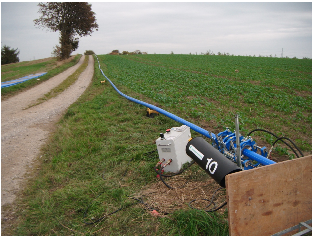
Figur 5: Stuksvejsning af ny forsyningsledning
