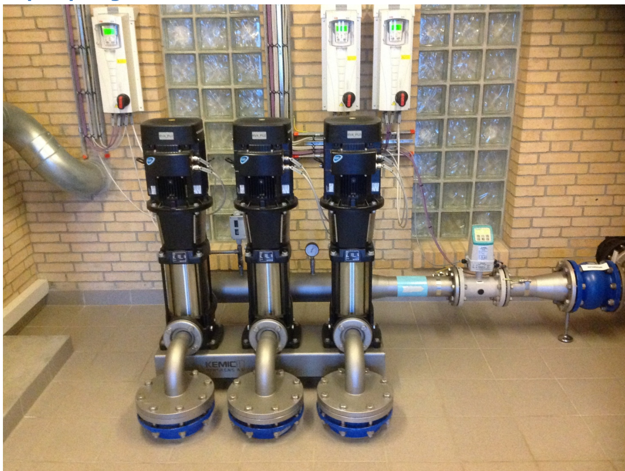
Figur 3: Rentvandspumper sektion 4.
