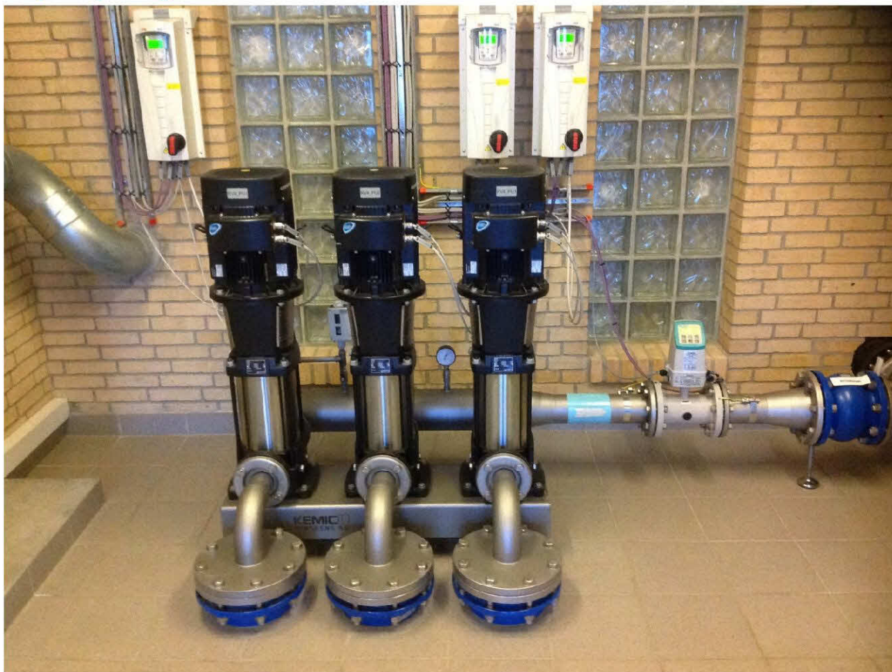
Figur 3: Rentvandspumper sektion 4.
