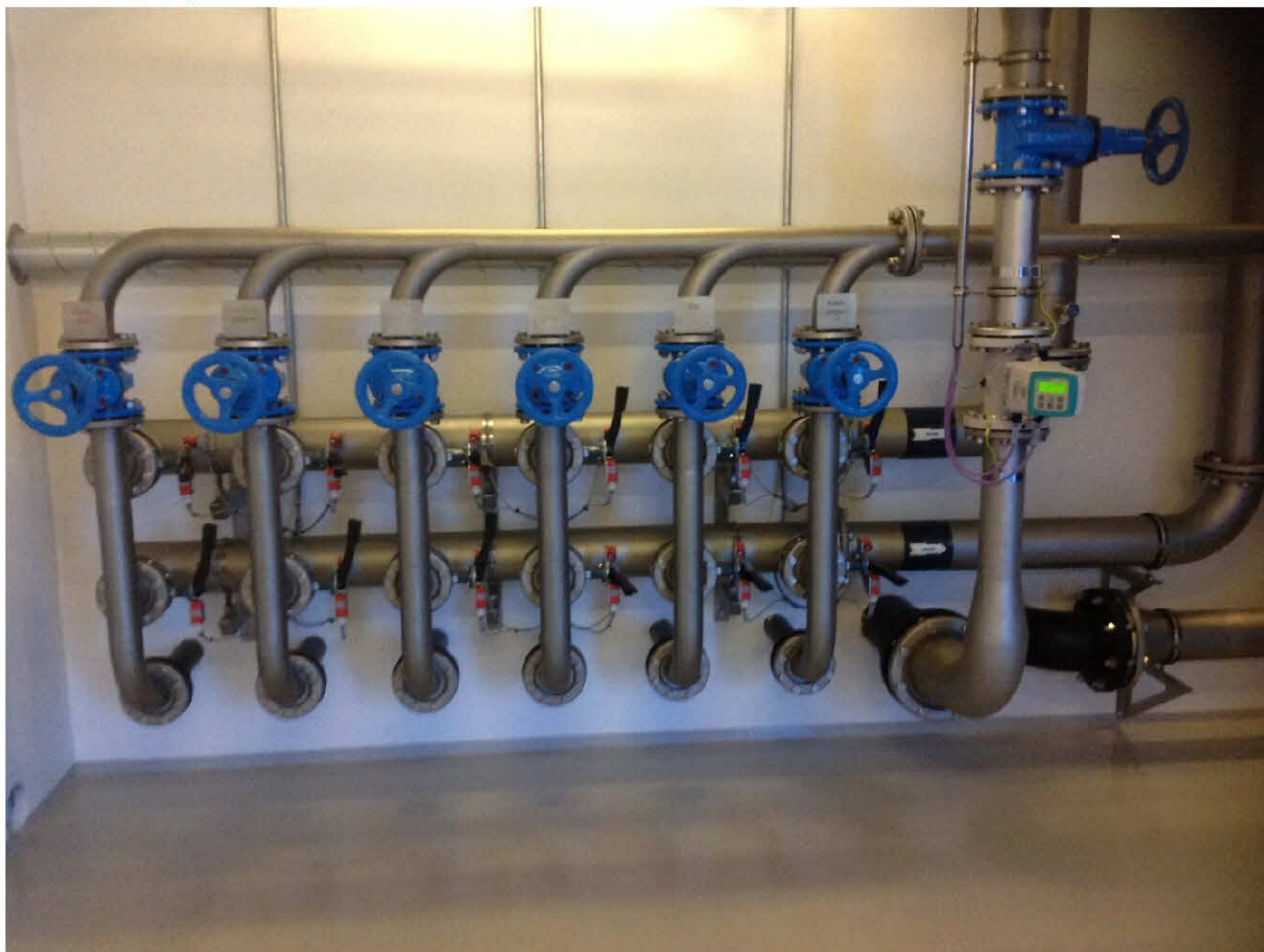
Figur 1: Fordelingsarrangement for råvand, kaldet vandorglet.
