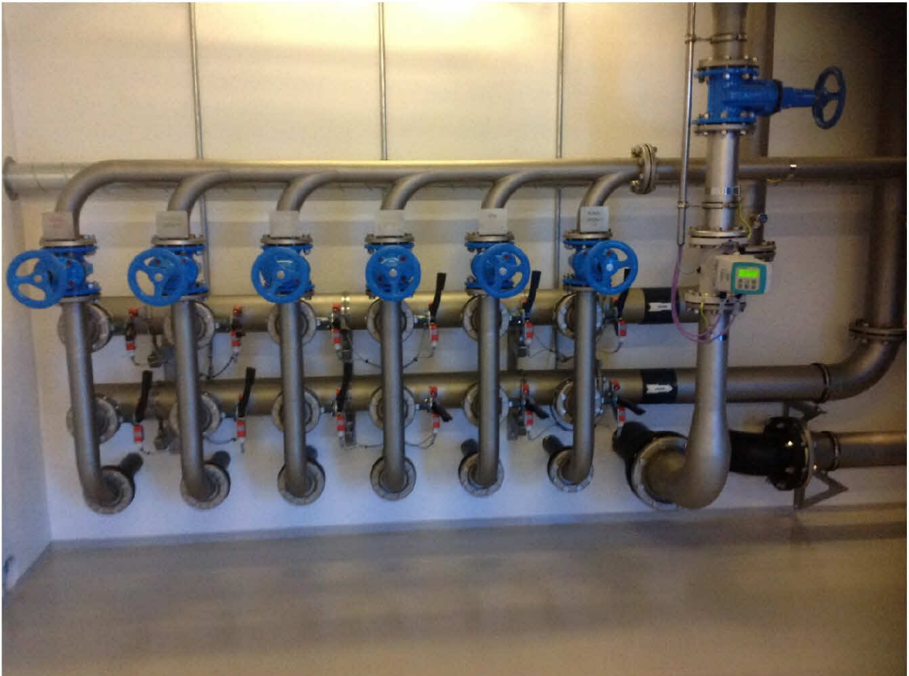
Figur 1: Fordelingsarrangement for råvand, kaldet vandorglet.
