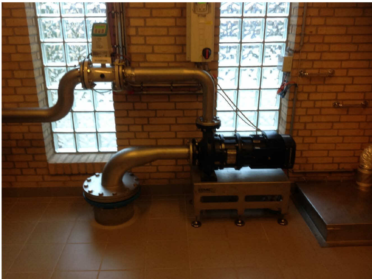
Figur 2: Skyllevandspumpe sektion 4
