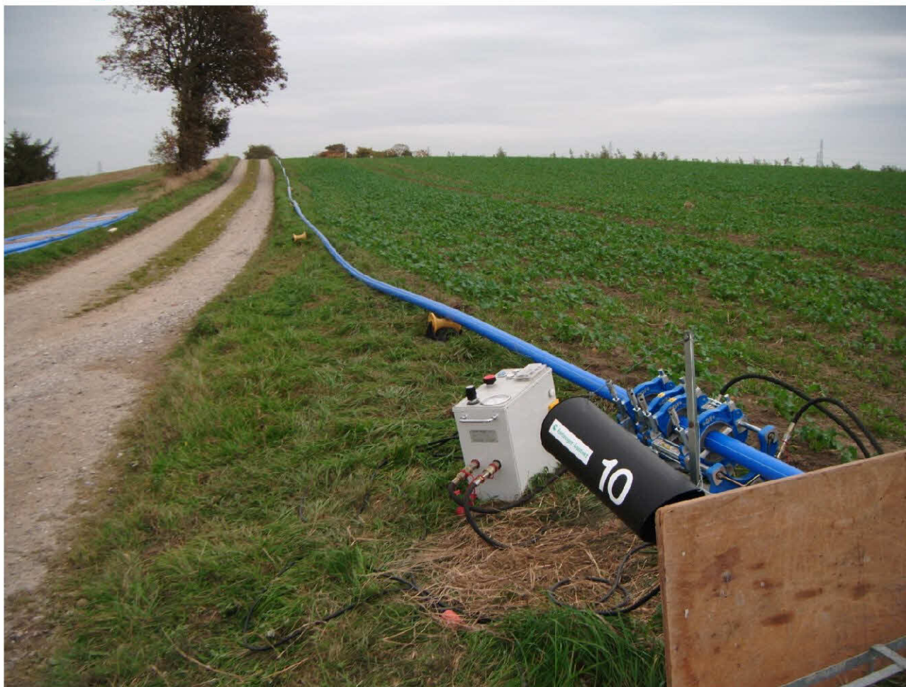
Figur 5: Stuksvejsning af ny forsyningsledning
