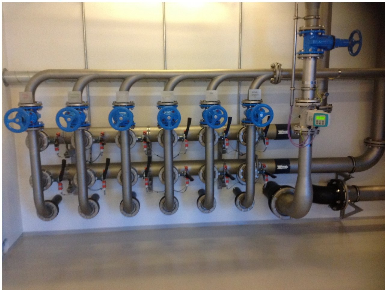
Figur 1: Fordelingsarrangement for råvand, kaldet vandorglet.
