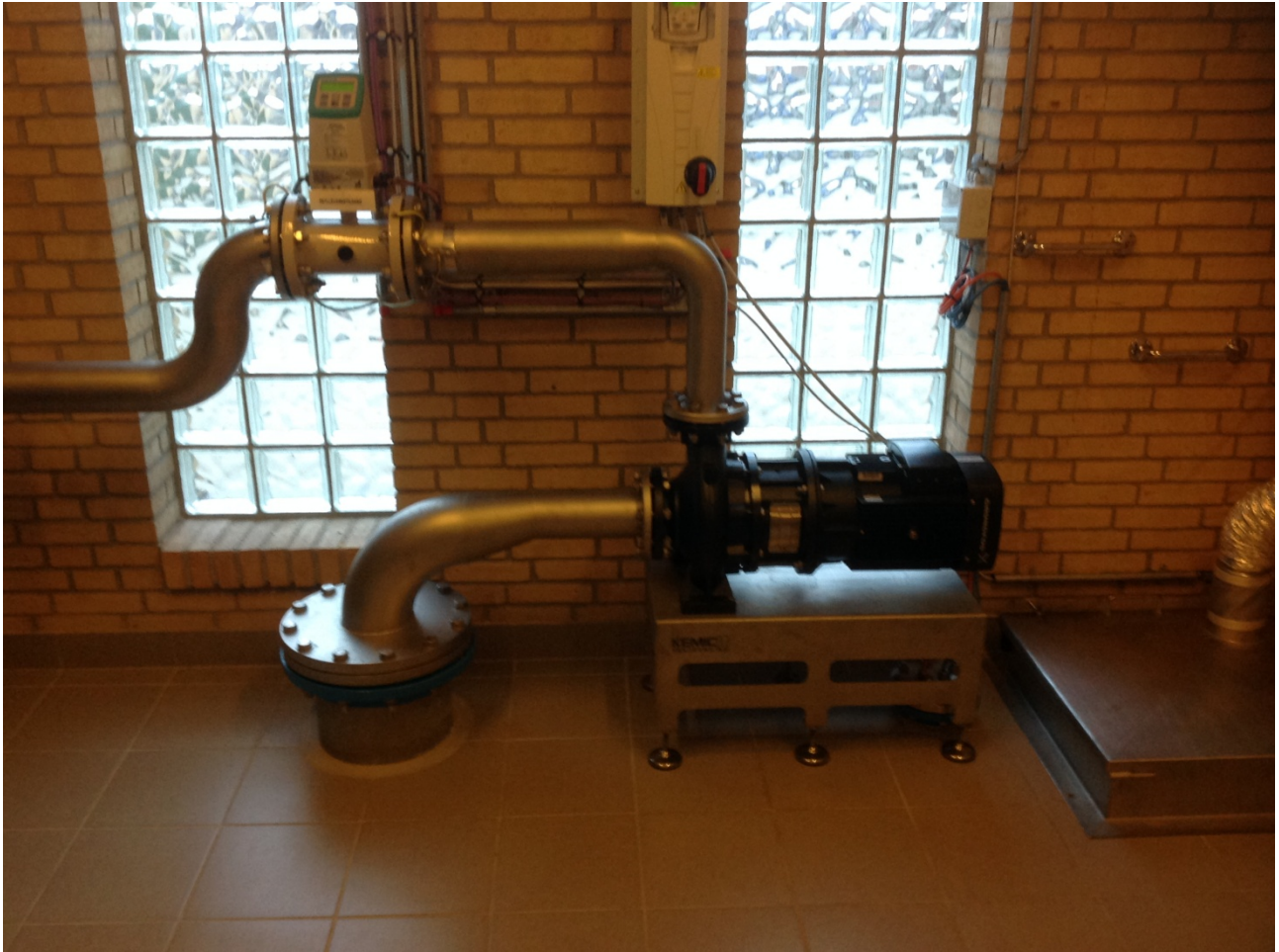
Figur 2: Skyllevandspumpe sektion 4
