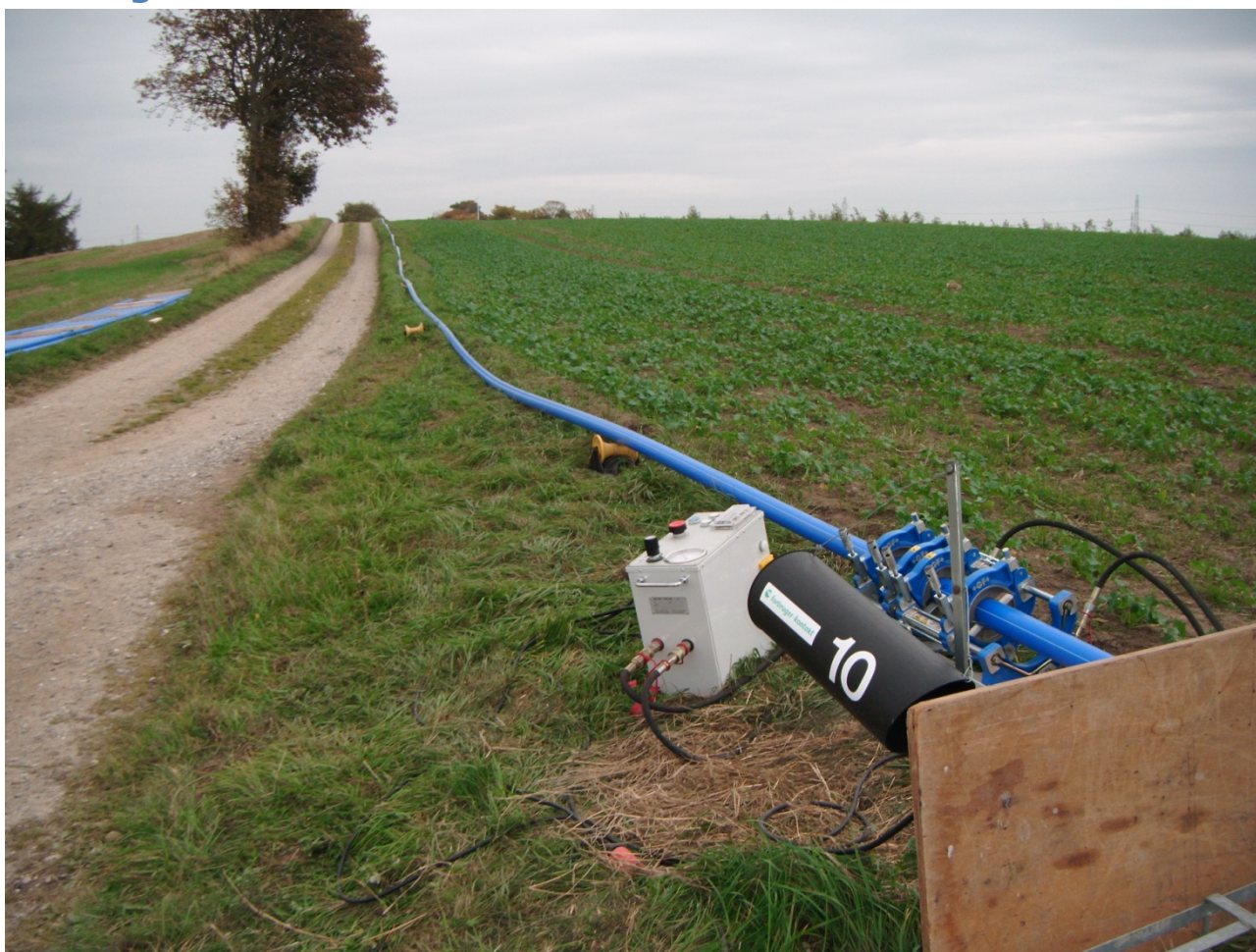
Figur 5: Stuksvejsning af ny forsyningsledning
