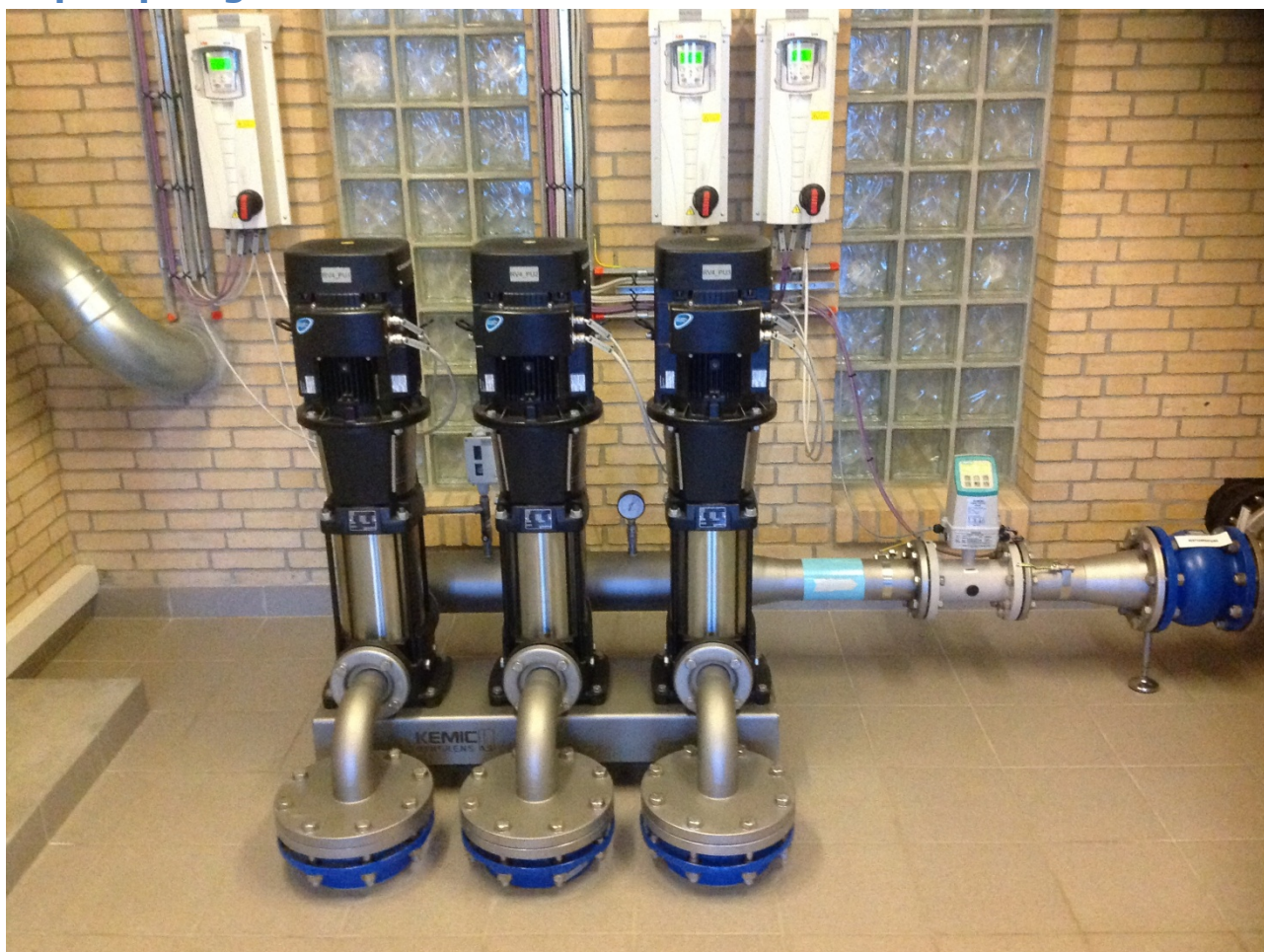
Figur 3: Rentvandspumper sektion 4.
