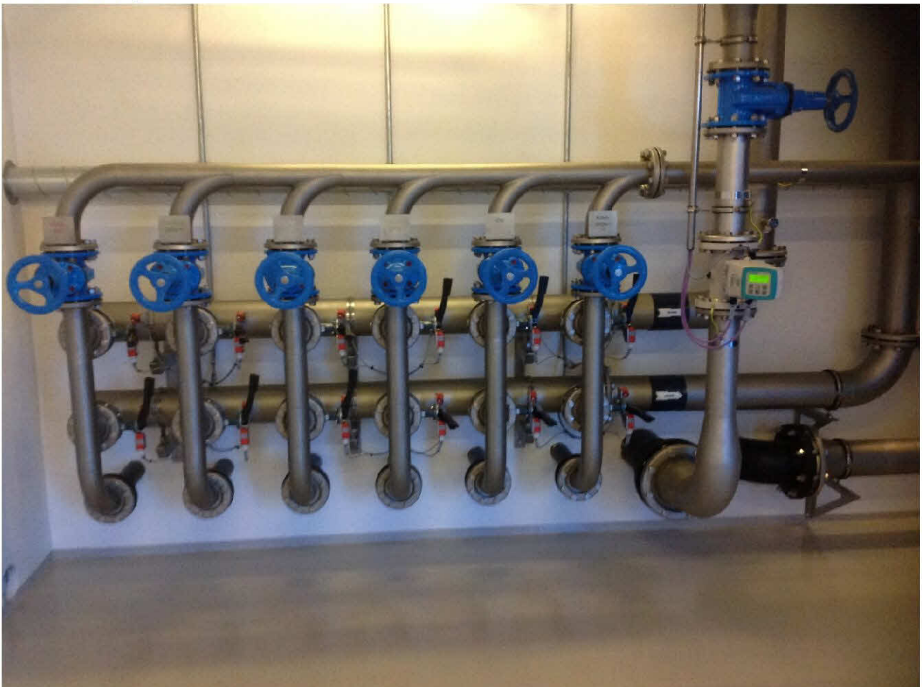
Figur 1: Fordelingsarrangement for råvand, kaldet vandorglet.
